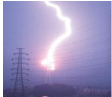
Abbildung 2 – Photo eines Rücküberschlages Bildquelle: CIGRE Technical Brochure 704
