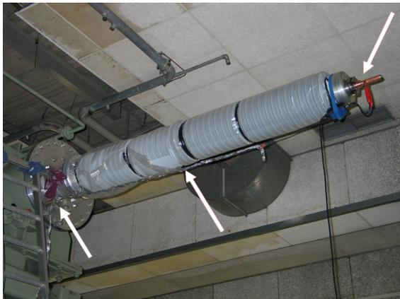
**Bild 3:** Ankopplung des Messsystems und Anschluss der Messerde an eine 400kV-Durchführung
